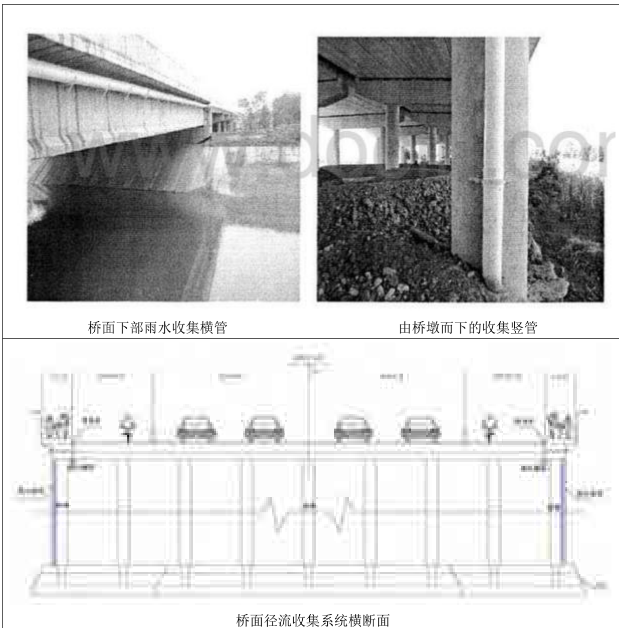
图 5.5-1 典型桥面径流收集系统横断面和实物图
